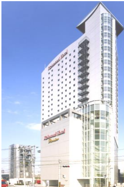
クレール小杉（ホテル側）写真
