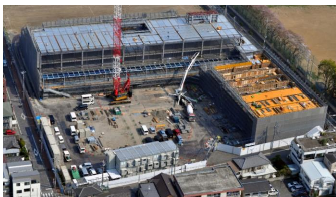
(工事現場写真)
