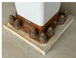
【鉄骨】柱脚ボルト締付 柱底均しモルタル
