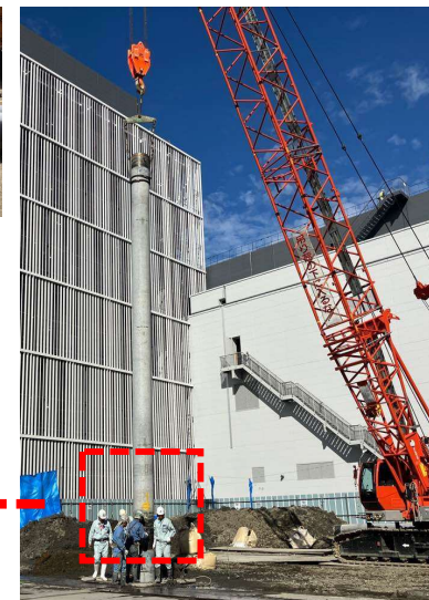
【杭】埋込み、T・Pジョイント(無溶接継手)
