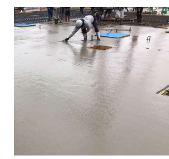
【コンクリート、左官】 コンクリート打設後、左官押え
