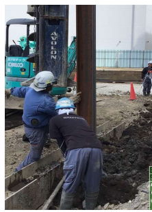
【山留】掘削、親杭(H形鋼)埋込み
