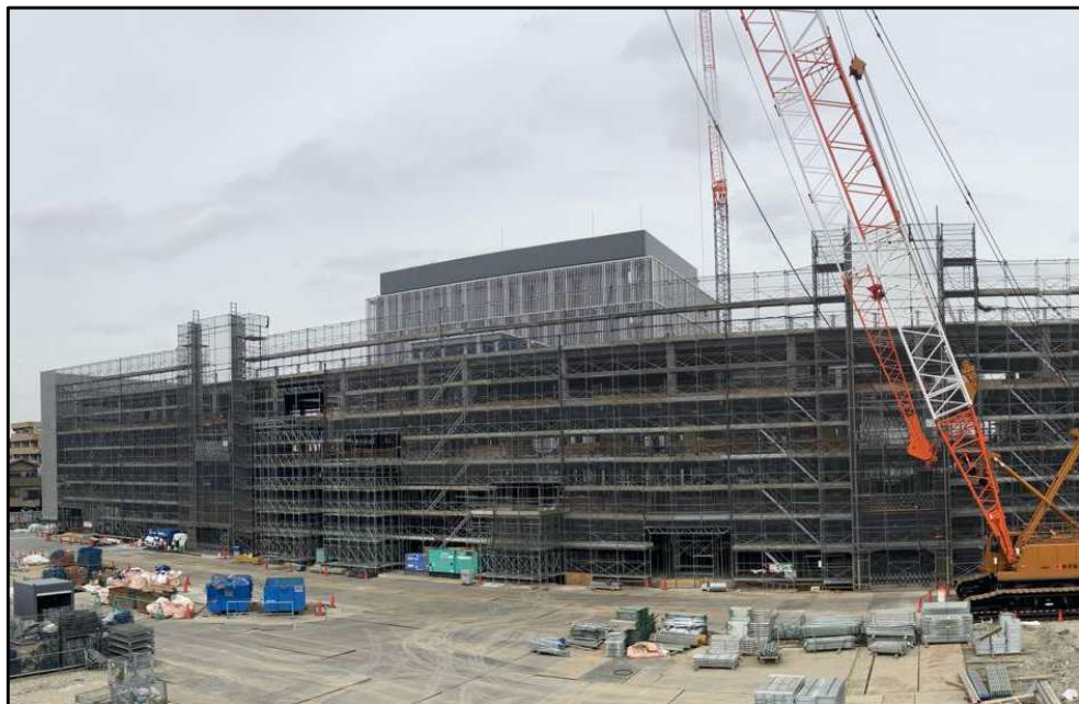
校舎棟南側 施工状況写真
