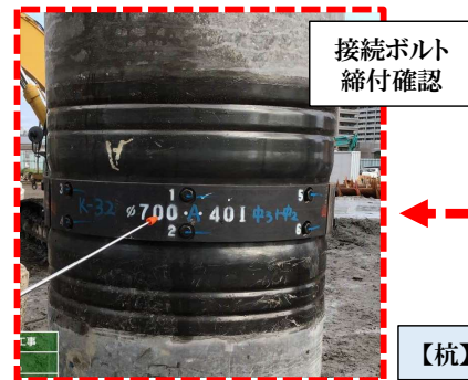
【杭】既製コンクリート杭製品検査
