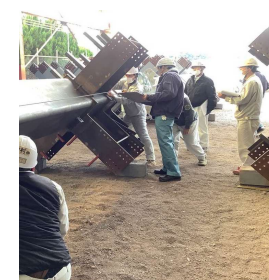
【鉄骨】製品検査
