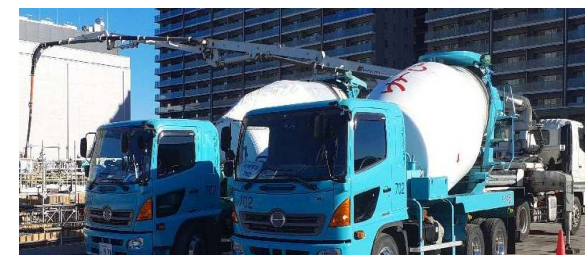
【コンクリート】ポンプ車打込み
