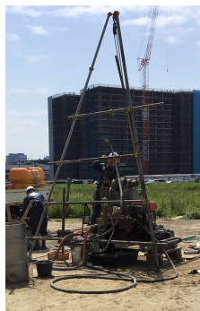
地質(ボーリング)調査
