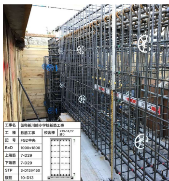
【鉄筋】基礎・礎柱配筋、アンカーボルト据付(左)、基礎梁配筋(右)
