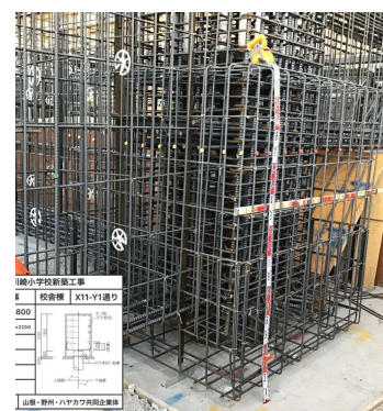
【鉄筋】基礎・礎柱配筋、アンカーボルト据付(左)、基礎梁配筋(右)
