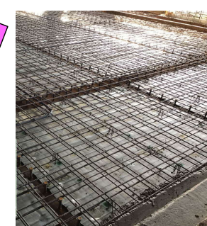
【鉄骨、鉄筋】 床版デッキ、配筋
