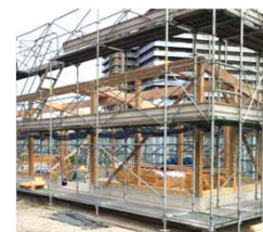
【躯体工事(屋外倉庫棟)7月～】 • 基礎スラブ・土台コンクリート、建方パネル取付状況
