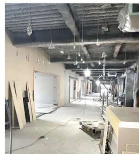
【内外装工事(校舎棟)7月～】 • 壁石こうボード取付状況
