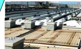
【太陽光発電設備(校舎棟)】 • 屋上設備基礎、架台、防水
