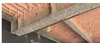
【内外装工事(校舎棟)7月～】 • 天井ウルトンフォーム(現場発泡)
