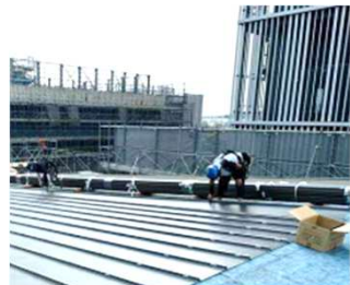
【屋根工事(体育館棟)8月～】 • ガルバリウム鋼板葺き状況
