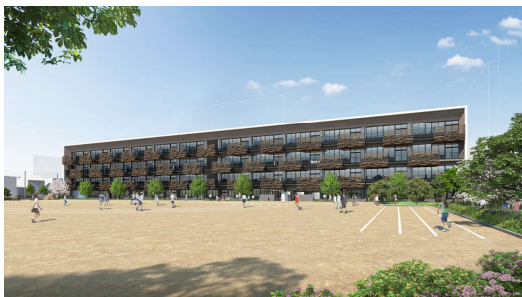
校舎棟南側 ・バルコニーが壁面を分節し、全面に児童の多様な活動があらわれる
