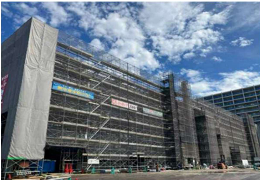
校舎棟南側状況写真
