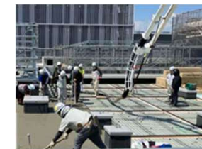
【防水工事(校舎棟)】6月～ • アスファルト防水施工後、断熱材敷設 • シンダー(保護)コンクリート打設
