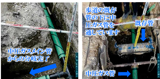
【外構】8月 中圧ガス引き込み施工状況
