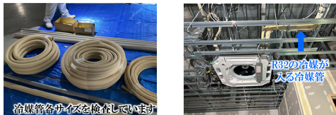
【校舎棟】8月冷媒管検査
