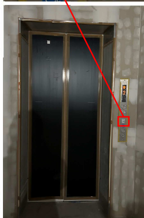
【校舎棟】11月 EV設置状況
