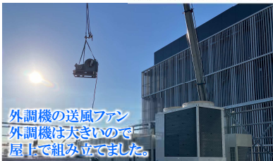
【校舎棟】9月外調機、室外機クレーンつり上げ施工状況
