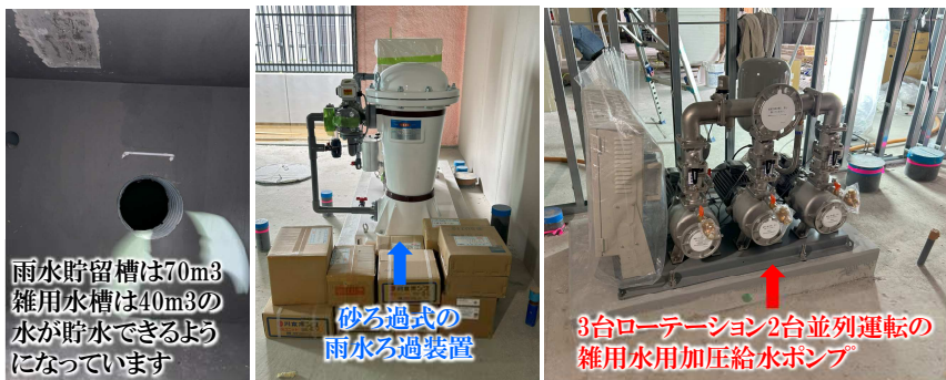
【体育館棟】10月雑用水槽、ろ過器、ポンプの施工状況
