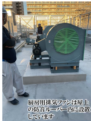
【校舎棟】10月 厨房排気の施工状況
