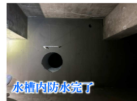
【校舎棟】10月 緊急排水槽施工状況
