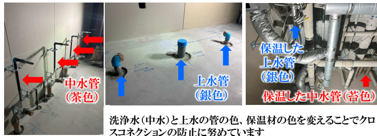
【校舎棟】10月 中水管と上水管の管と保温の施工状況
