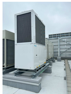
【校舎棟】9月 自立型GHP施工状況
