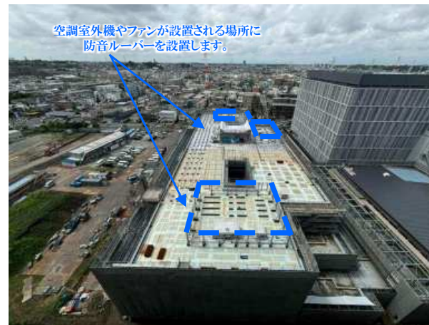
【校舎棟】9月 屋上の騒音対策(防音ルーバー)
