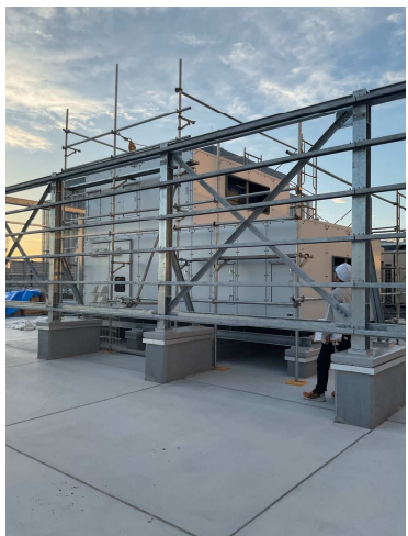
【校舎棟】9月外気処理空調機施工状況
