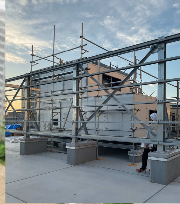
全熱交換器付外気処理空調機
