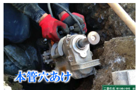
【外構】R5.1月 耐震管(本管)施工状況
