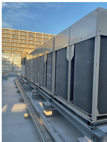
【校舎棟】10月高効率型空冷HPパッケージ施工状況
