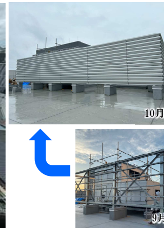
【校舎棟】ルーバーの施工状況
