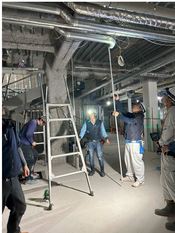
校舎棟1F天井内収まり検討写真
