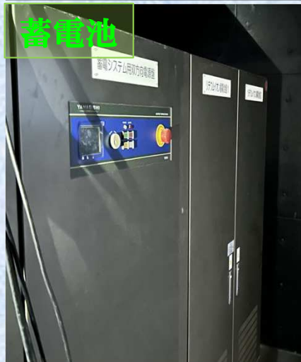
【校舎棟蓄電池室】12月 蓄電池盤設置状況
