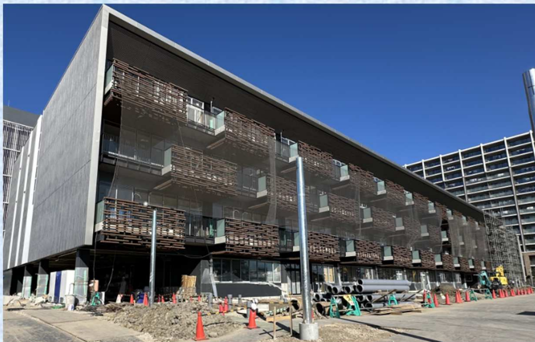
校舎棟南側状況写真
