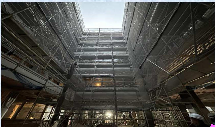
【校舎棟1階庭】11月自然光取入れ状況
