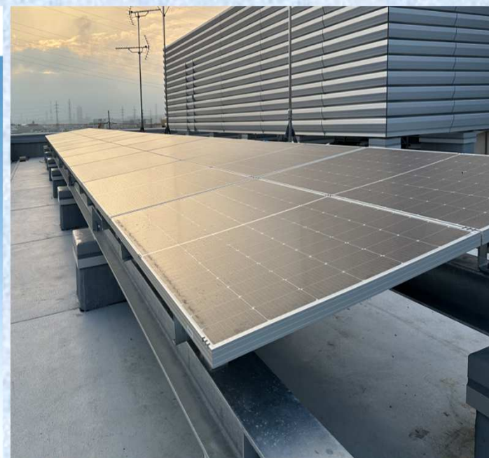
【校舎棟屋上】11月 太陽光パネル設置状況
