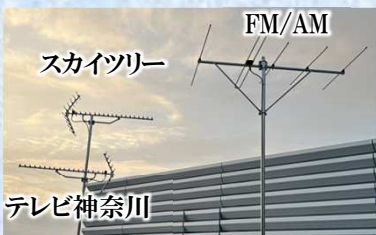
【校舎棟屋上】11月 アンテナ設置状況
