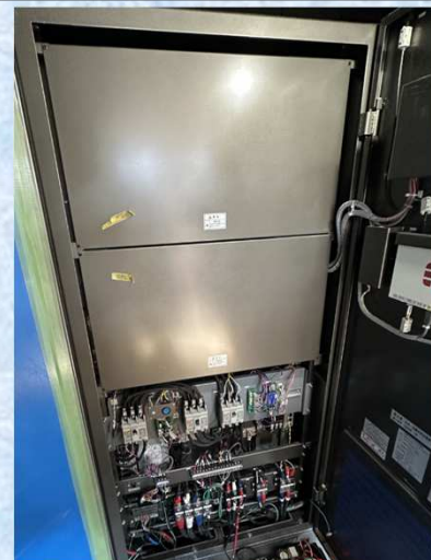
【校舎棟蓄電池室】12月 蓄電池盤設置状況
