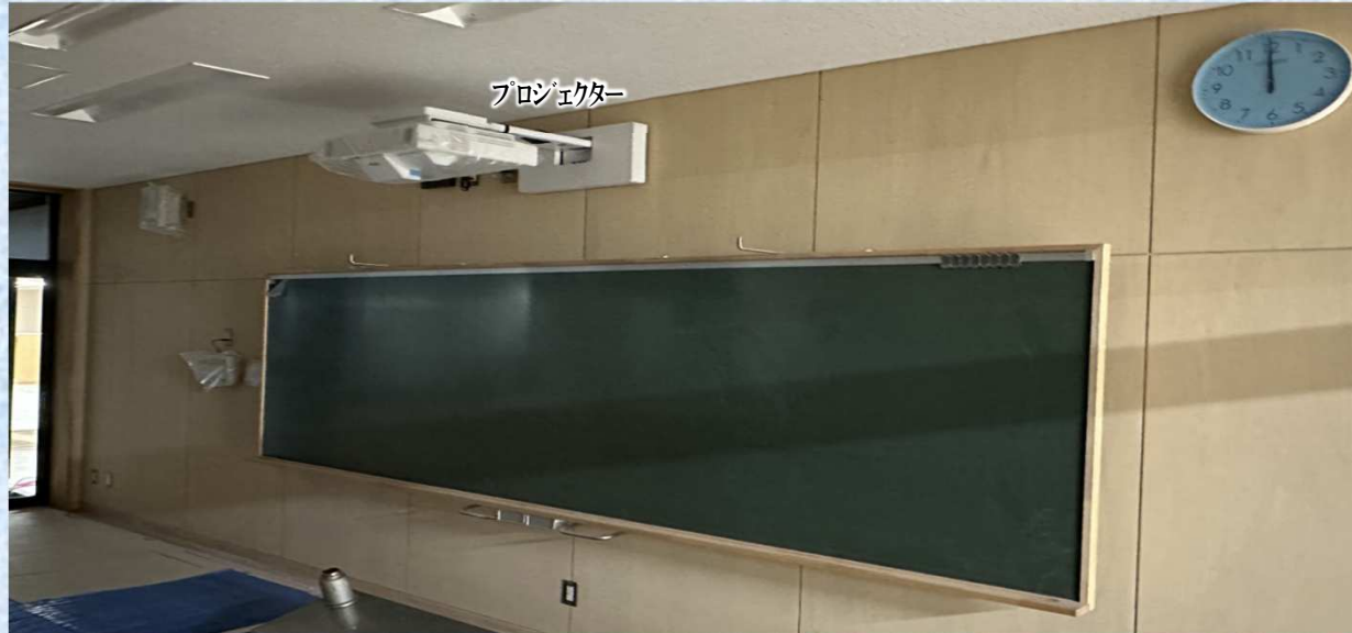
【校舎棟】12月 プロジェクター設置状況
