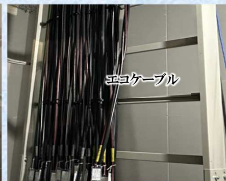
【校舎棟配線スペース】11月 幹線ケーブル施工状況
