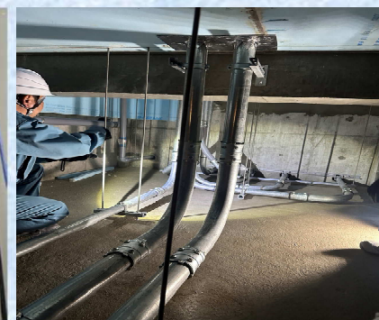
【校舎棟ビット】9月 幹線ケーブル施工状況
